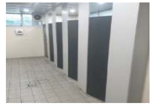
남녀 화장실 공사 (110백만원)
