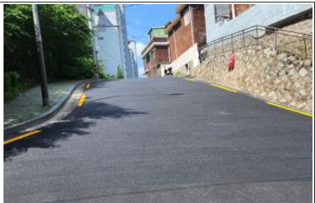
미끄럼포장 및 도로열선설치
