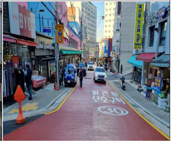
현황사진(지중화 관로공사 완료)
