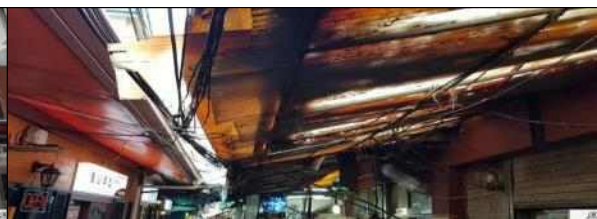
미 설치 구간(160m)
