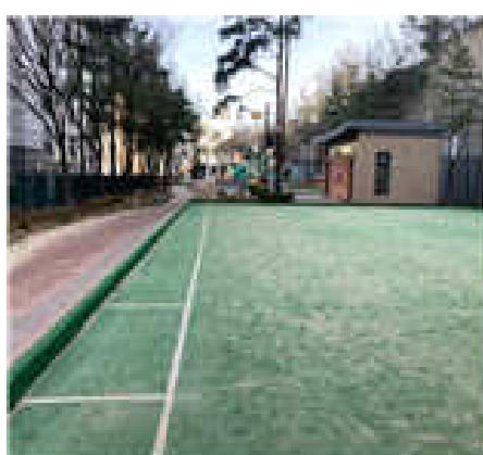
(공사 전) 게이트볼장
